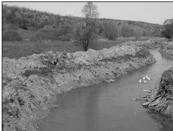
2. kép: Csaholyi-patak kotrás után, Olábcsaboly
